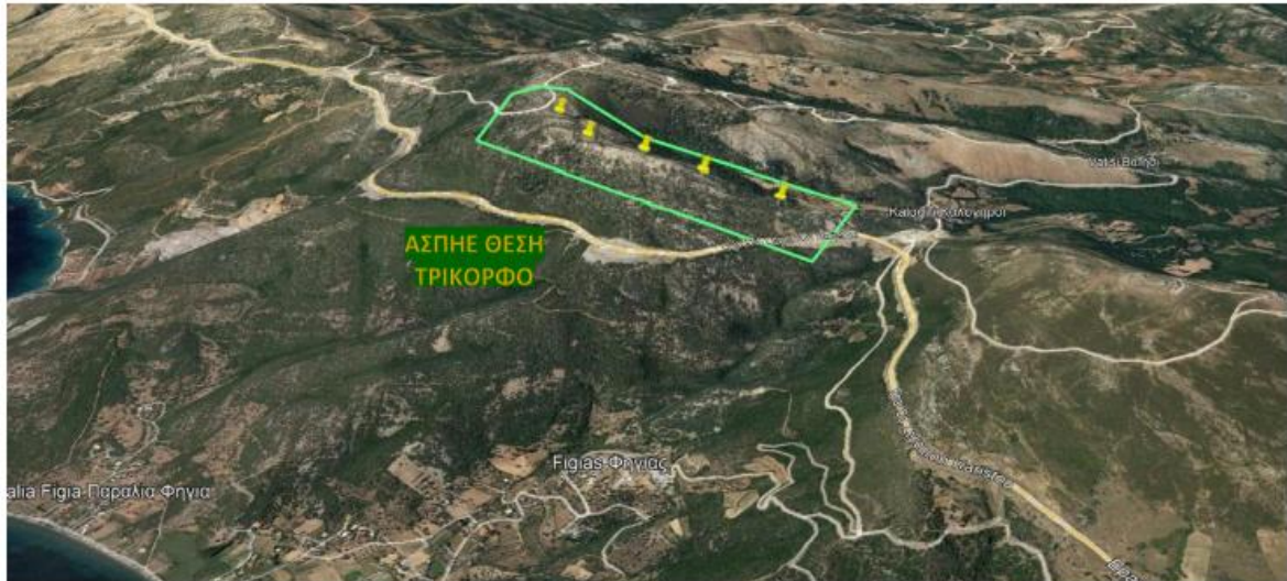
Εικόνα 8-8: Θέση ΑΣΠΗ ΤΡΙΚΟΡΦΟ σε σχέση με την ευρύτερη περιοχή (πηγή: Google Earth)
